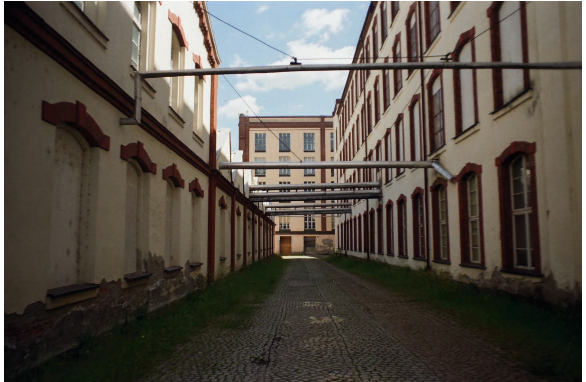
Abb. 50 - Ein Blick auf die durch die Zwirnerie und das Produktionsgebäude B ge- formte Gasse, 2025
