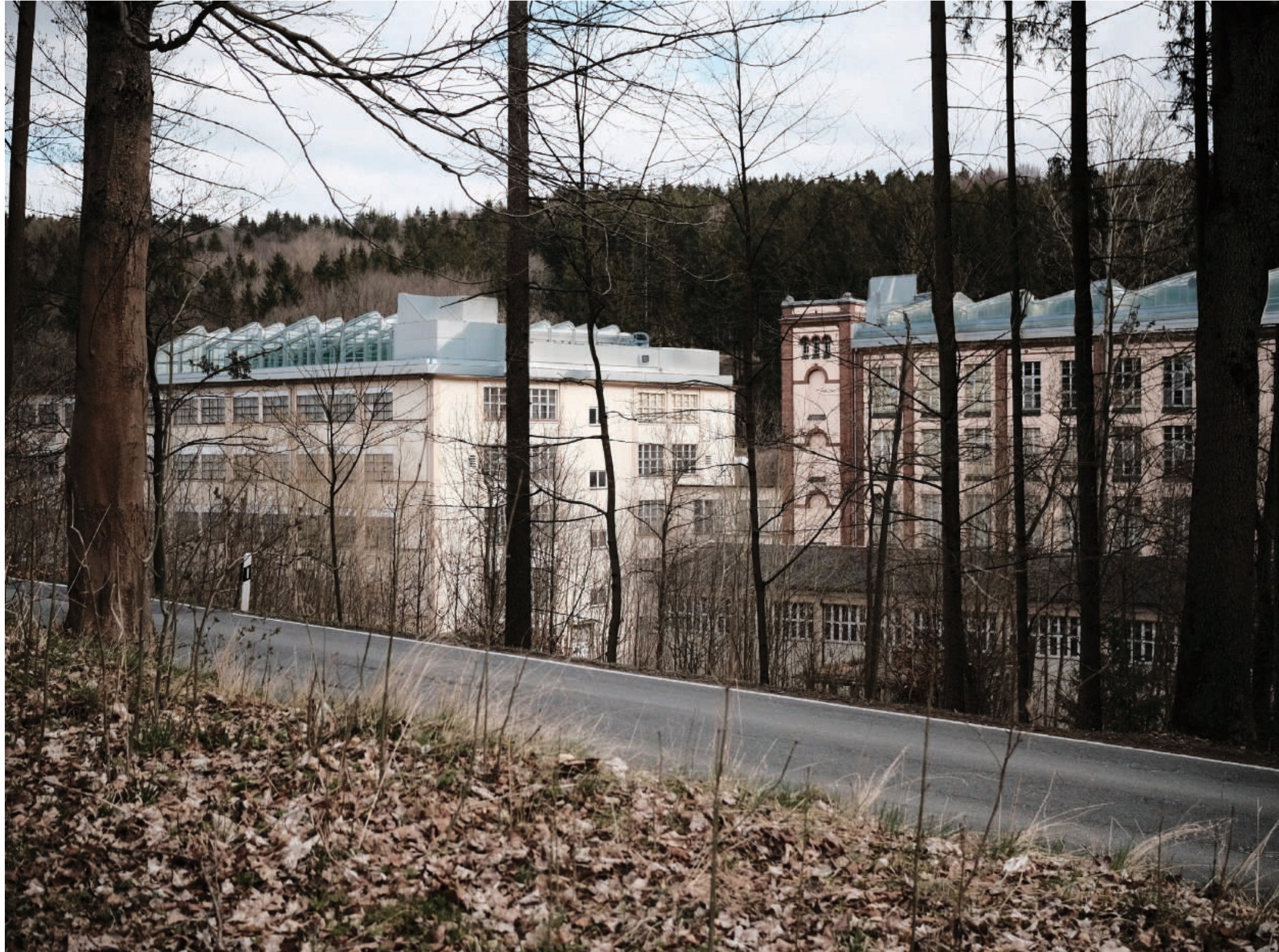
Abb. 97 - Ein Anblick der modernisierten Spinnerei Venusberg II von der Seite der Talstraße. Im vorbeifahren glänzt das Industriedenkmal mit den neu integrierten Agrartechnologien
