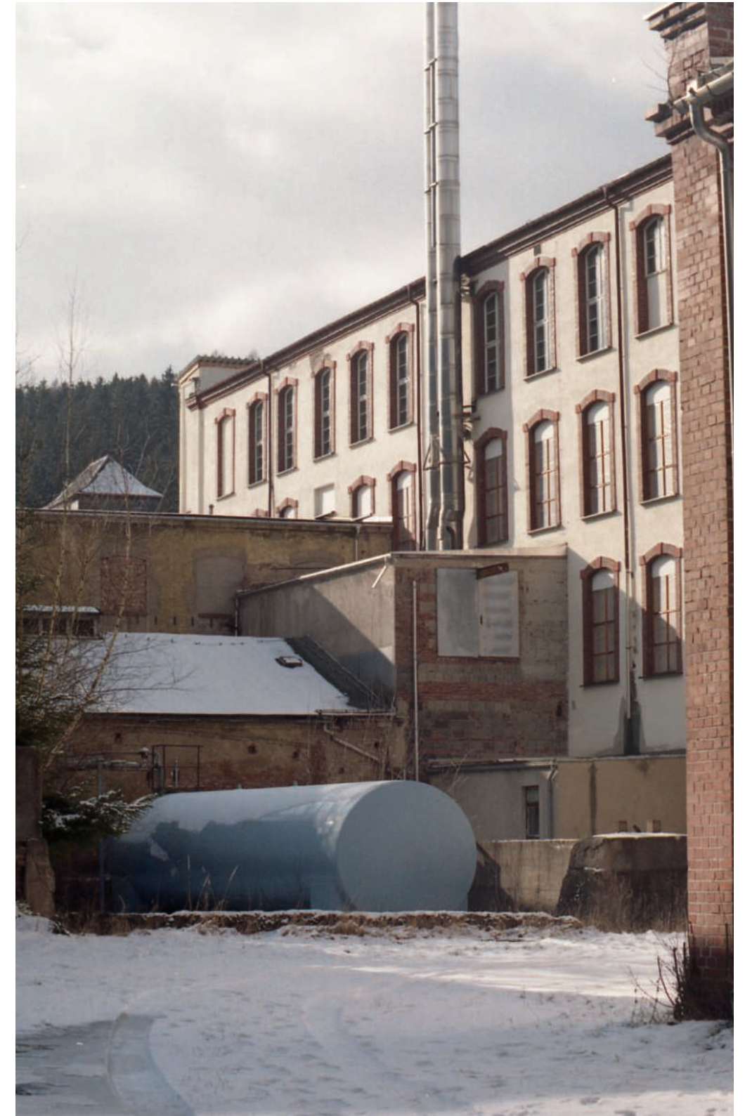
Abb. 48 - Ein Blick auf die ehemaligen Heizhäuser und spätere Zubauten am Produktionsgebäude B, 2025
