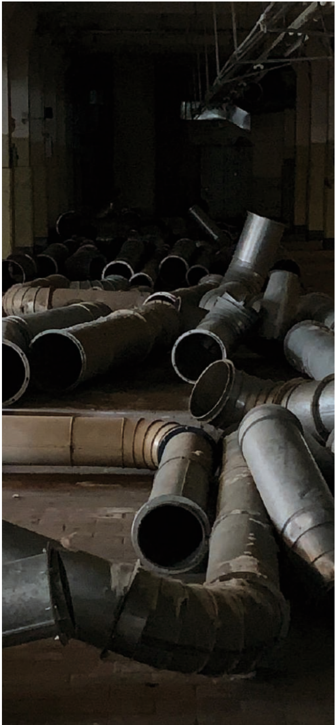
Abb. 70 - Übrig gebliebene Rohrsysteme weisen auf die Anpassung und Egnung der Bausubstanz für Prozesse zur Garnherstellung, welche eine hohe klimatische Kontrolle erfordern
