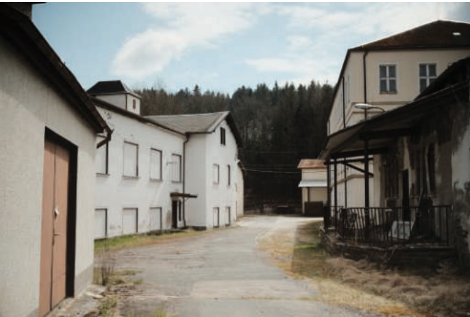
Abb. 86 - Orthografische Aufnahme des Zugangs zum Spinnereigelände nach dem Rückbau der Bauwürdigen Gebäude
